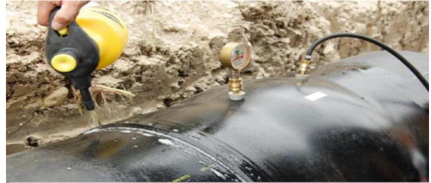
배관 용접부 연결 시 완전한 방습구조로 시공하여 수분의 침투를 방지
