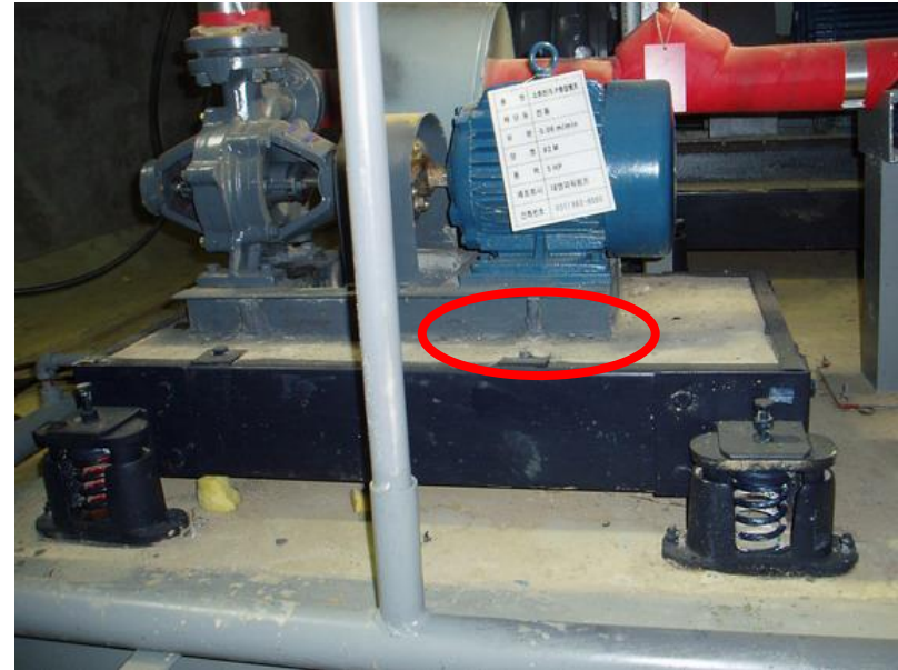
기초 공사 양호
